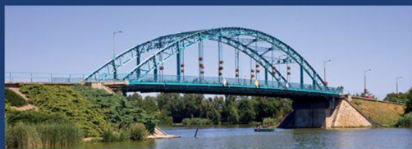
Ráckeve – Árpád Bridge
